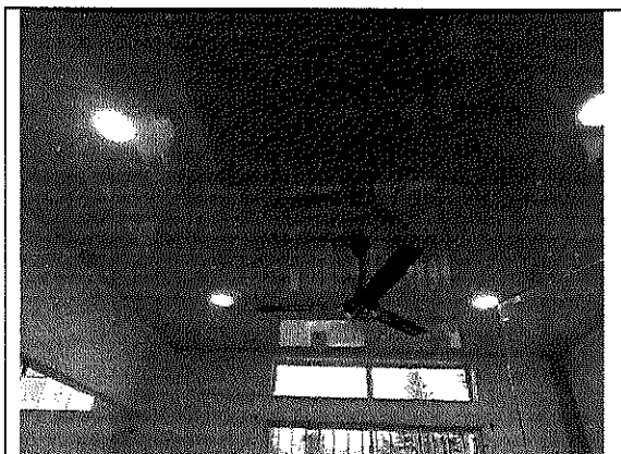
Cielo raso en PVC, incluye perfilaría, ventilador de techo KDK y bala tipo LED
